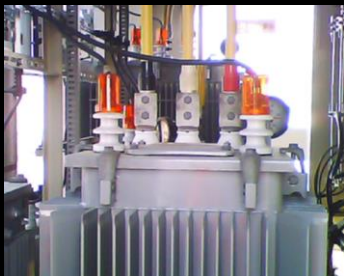
サーモグラフィーによる検査
